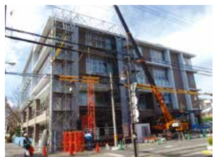
外装工事後の外観
