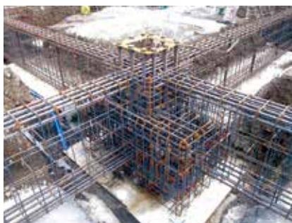
基礎鉄筋工事
